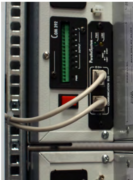
Параллельное подключение и плата контактов программируемых реле
